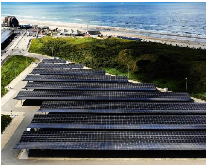
Figuur 27: Zonnecarport Bloemendaal – 5.000 zonnepanelen
